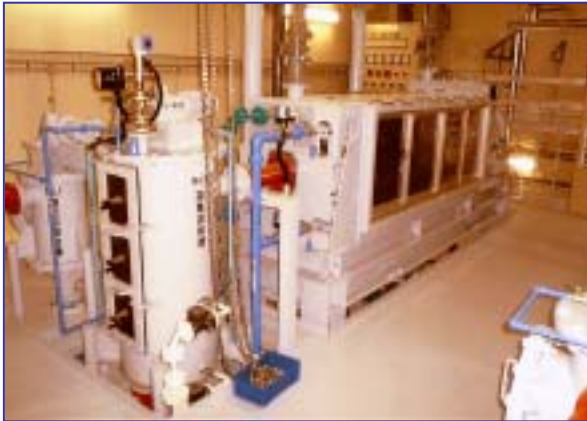
<西部スラッジセンター・定山溪脱水施設> スクリーブレス脱水機
